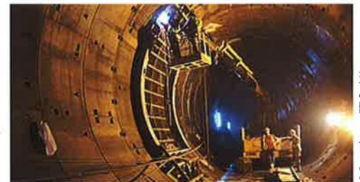
Die Querschlag- erstellung im TBT in Istanbul.
